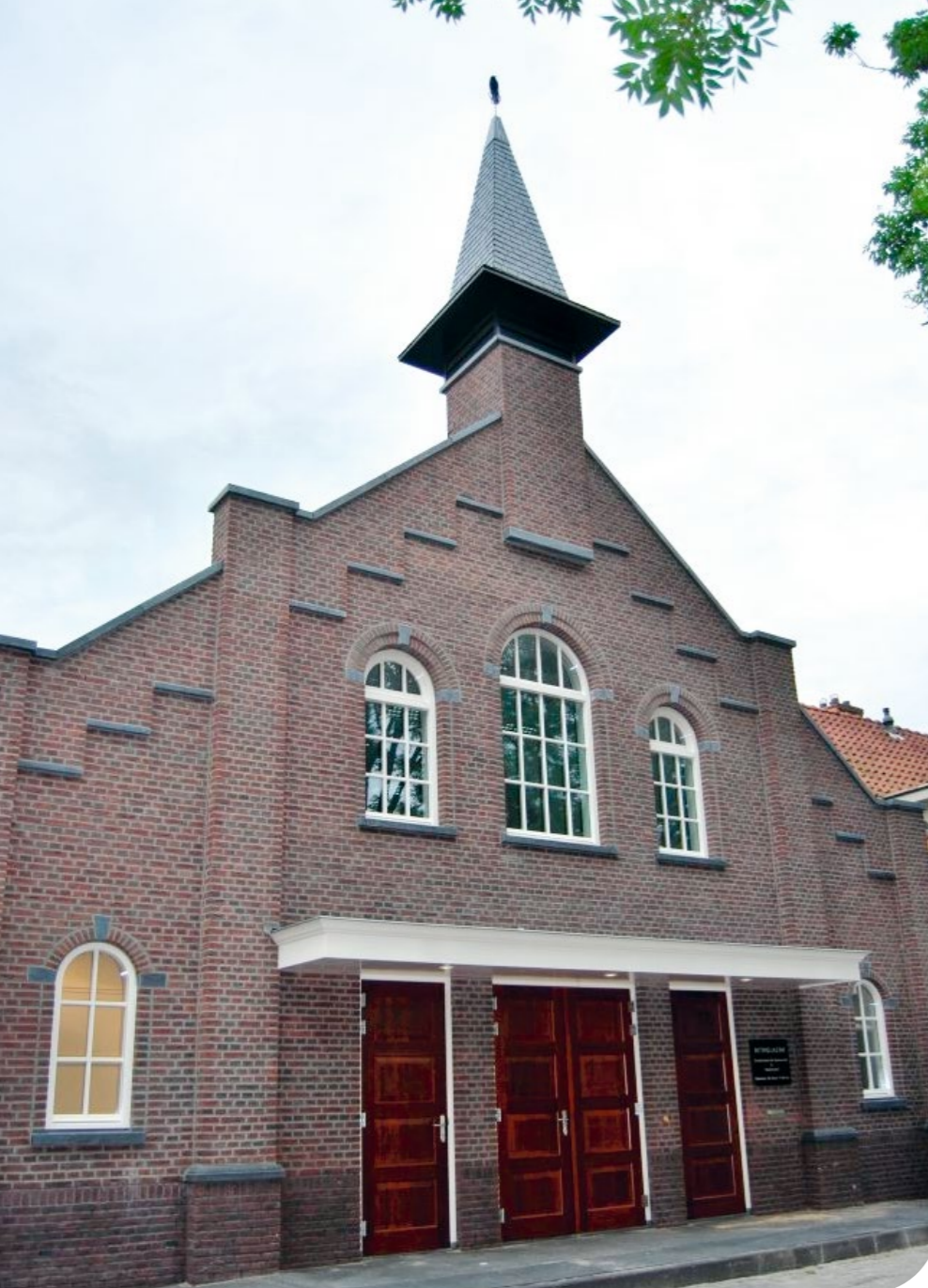
➤ Kerkgebouw GGin IJsselmuiden
